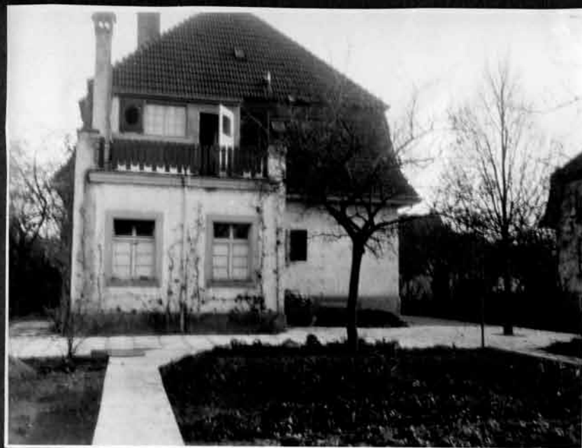
ECCO IL LAVORO DEL MURATORE
